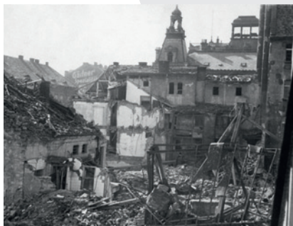
Pohled z ruin budovy knihovny na dnešním Lidickém náměstí směrem k bývalé poště v dnešní Revoluční ulici
