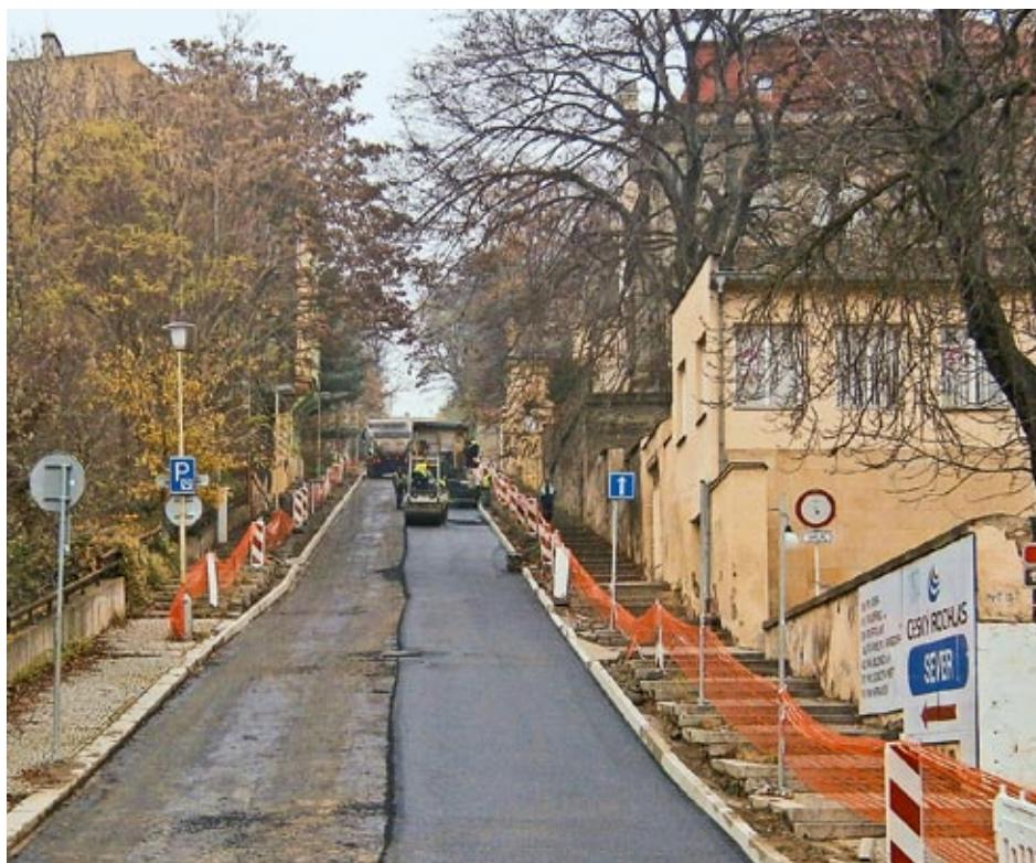
Oprava ulice Na Schodech
