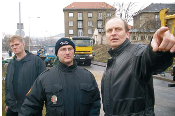
Primátor Gandalovič řídí práce na stavbě nábrežní hráze.
