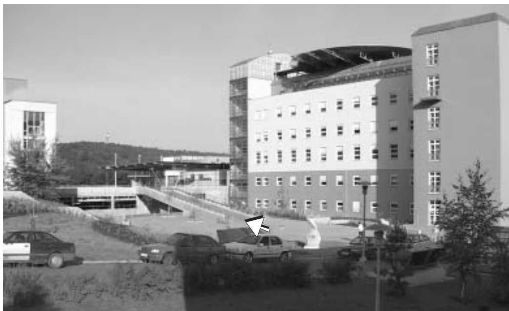
Budova s heliportem, šipka značí vchod do atria.
