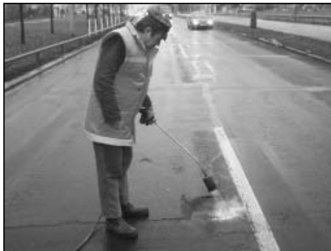
Po vymetení a vysušení je výtluk zasypán studenou směsí
