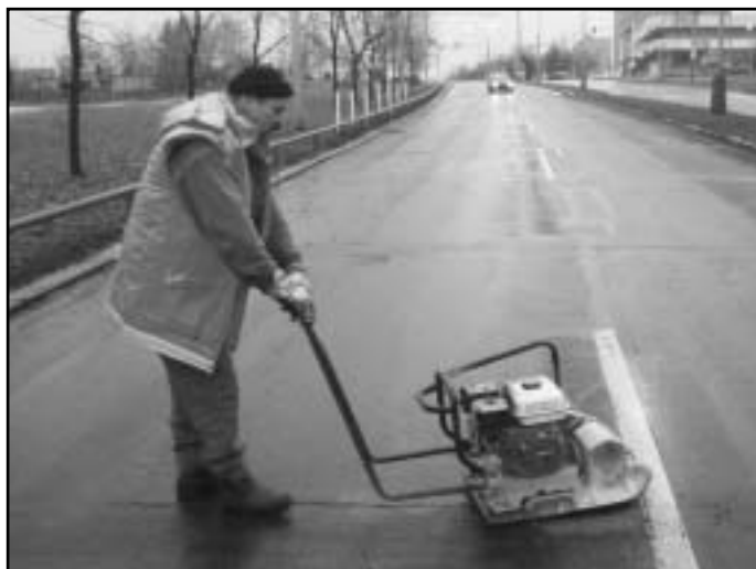
Vybrační deska poté provede konečnou úpravu
